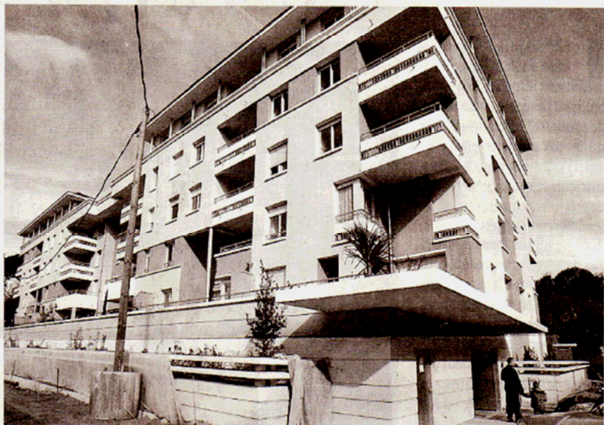
Aux Terrasses de la Garonne (Opac) un T3 coûte moins de 400 € par mois. Photo DDM. X. de Fenoyl.
