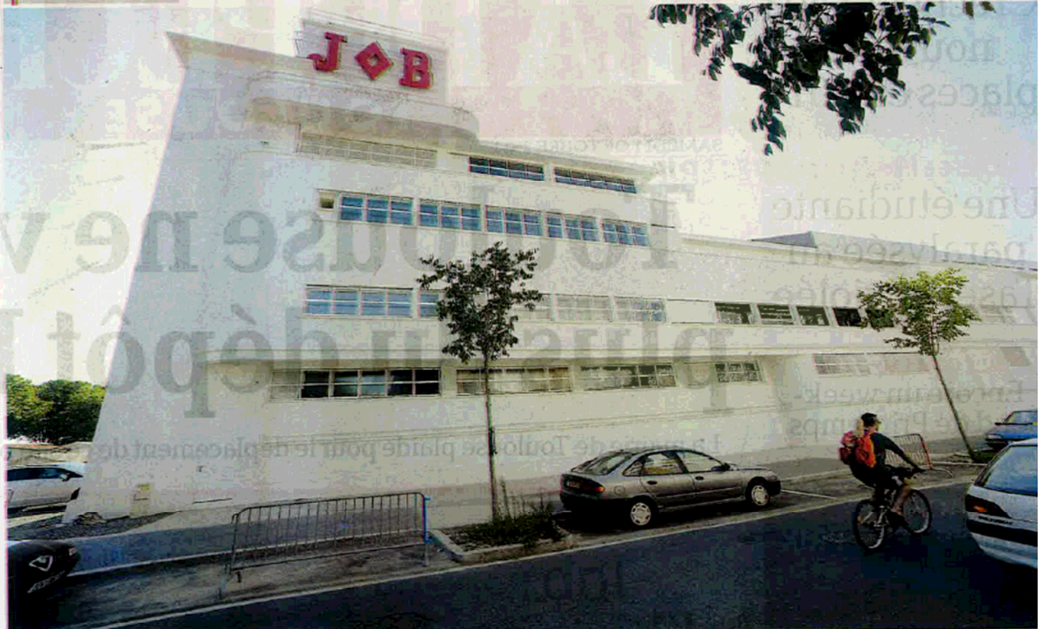
L'élégante façade dessinée en 1937 par l'architecte Pierre Thuriès, restaurée, abrite désormais salle de spectacle, école de musique, MJC et piscine municipale / Photo DDM-Michel Viala
