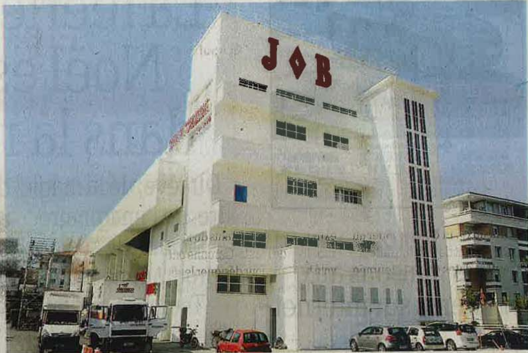
Une seconde vie publique pour un bâtiment industriel historique. / Photo DDM, Michel Viala
