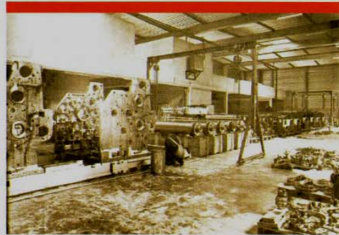
La salle des machines de Chabrillac (en sa construction) Emprise Chabrillac (1977)
