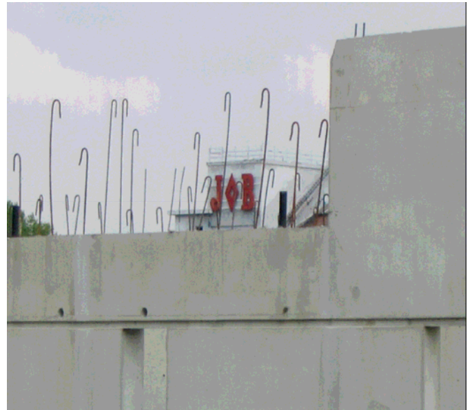
CONSTRUCTION SUR LE SITE JOB (AVRIL)
