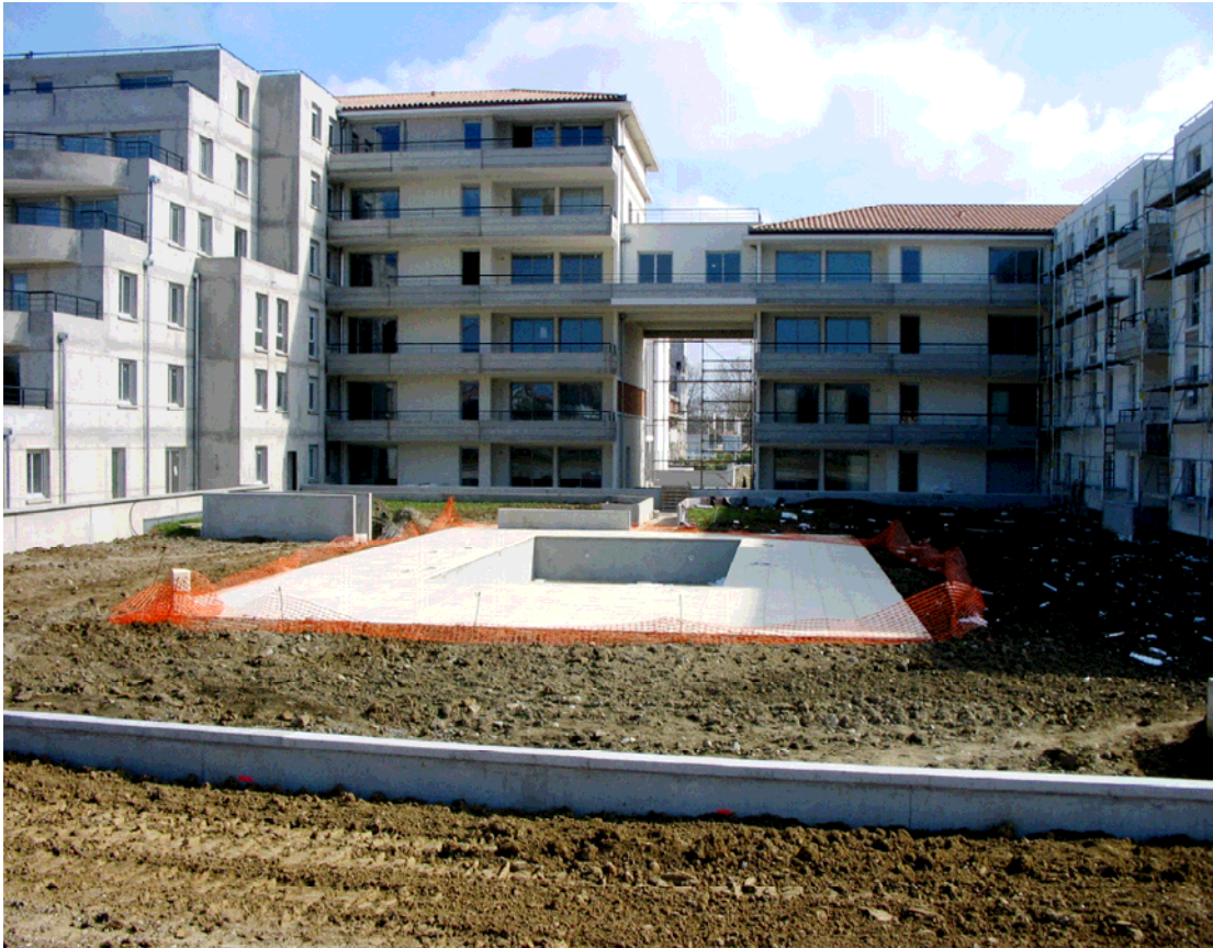
CONSTRUCTION SUR LE SITE JOB (AVRIL 2007)
