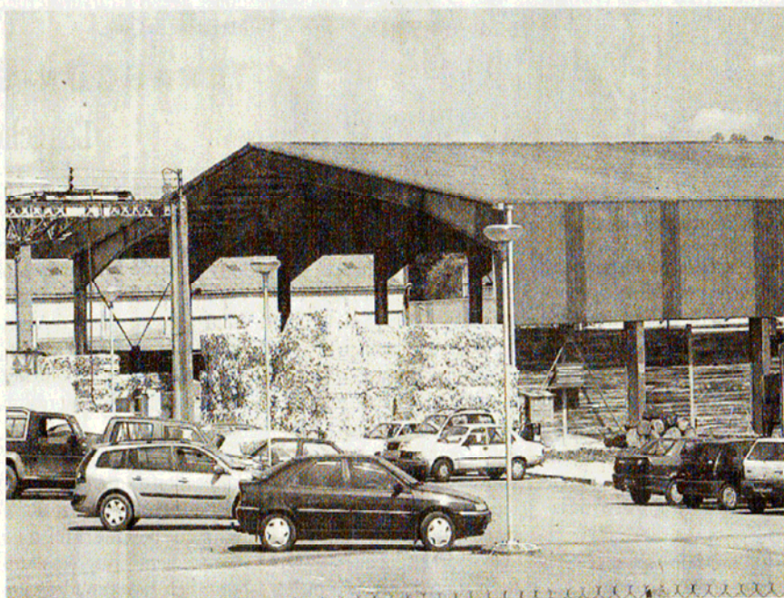
A Lédar les machines ne tournent plus. Photo DDM
